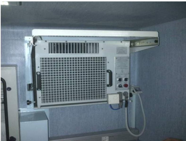
Esempio di montaggio su guide all' interno di uno shelter Example of rail-Mounting inside a shelter
